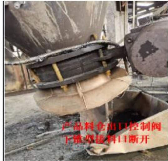
(照片 6) 产品料仓出口控制阀下锥型接口断开
