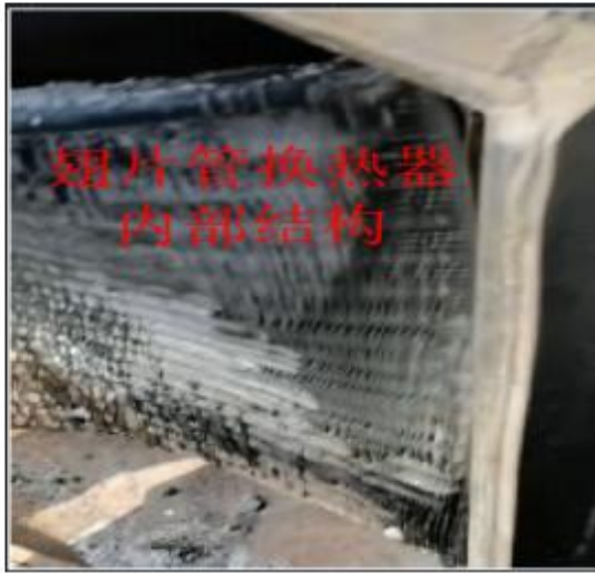
(照片 5) 翅片管换热器内部结构
